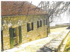
Staržarnica, danas restoran.
